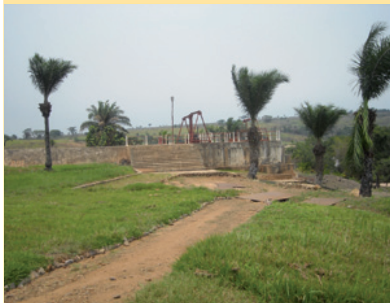
De hydro-elektrische stuwdam van Lungudi in Tshikapa (Kasai), september 2008. Le barrage hydroélectrique de Lungudi à Tshikapa (Kasai) en septembre 2008. Lungudi hydroelectric dam at Tshikapa (Kasai) in September 2008.
